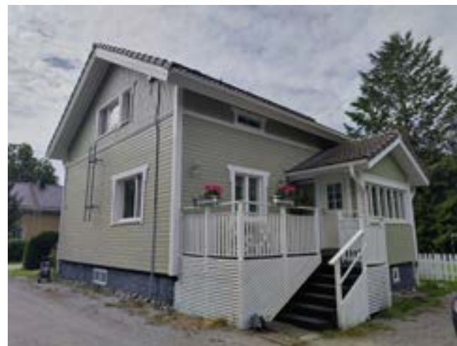
Kuva 15. Kivistö, päärakennuksessa on kuisti sekä sen yhteydessä taressi. Kuva: Matilda Mettovaara, 2026.
