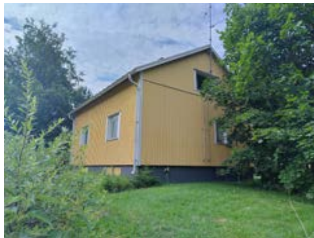
Kuva 12. Kallio, asuinrakennuksen julkisivut ovat pysty-laudoitettuja ja peiterimoitettuja. Kuva: Matilda Mettovaara, 2026.
