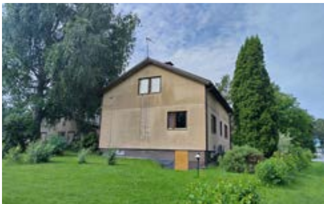
Kuva 6. Raitala, 1940-luvun lopulla valmistunut julkisivuiltaan levyverhoiltu päärakennus. Kuva: Matilda Mettovaara, 2026.
