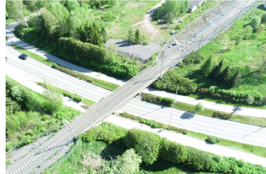
Kuva 22. Vistan alikulkusilta nykytilassa. (Kuva: Joonatan Lagerström)
